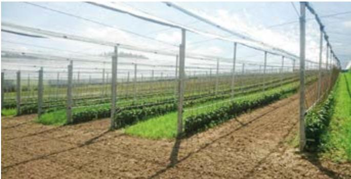
Extrem hohe Windstabilität durch eine effiziente Kombination von Bungy, Traufendraht und Querverspannung (stabil nach oben, elastisch nach unten).
